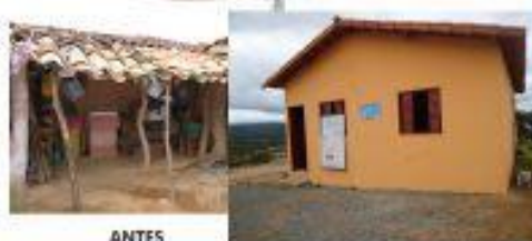
Construção da casa de uma assistida
