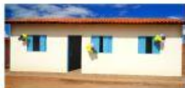
Construção da casa de um assistido
