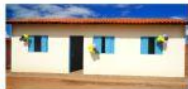
Construção da casa de um assistido
