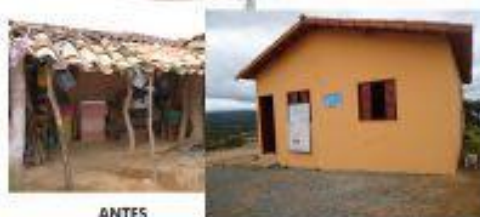
Construção da casa de uma assistida
